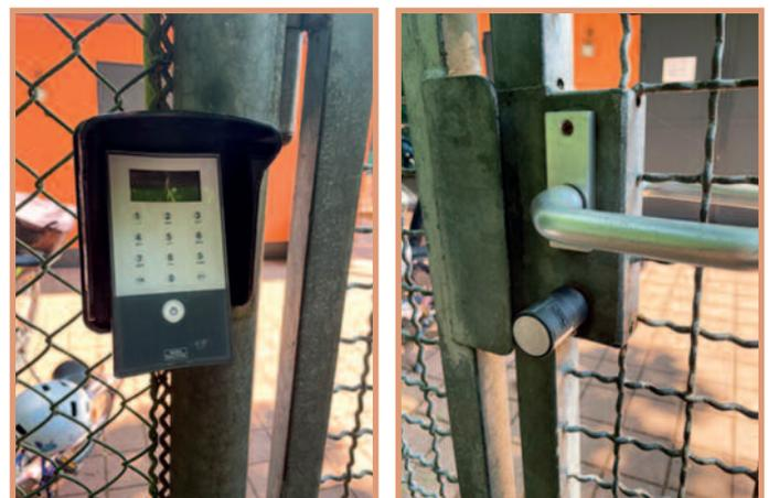
Zur Eingabe erst das Gerät am Knopf unten einschalten, dann den sechsstelligen Code eingeben. Bei korrekter Eingabe kann das Tor durch Drehen des Zylinders geöffnet werden.
